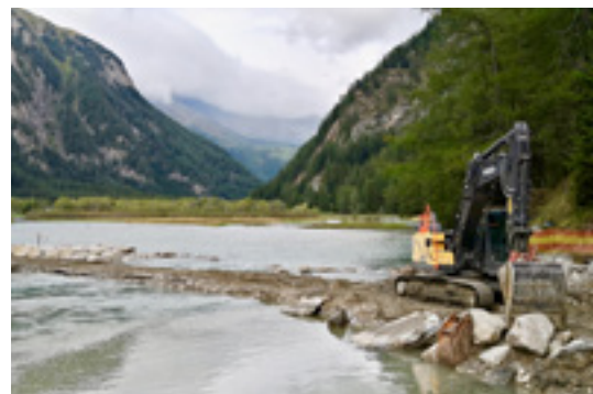
Asportazione dei sedimenti presso il bacino artificiale di Vizze.
