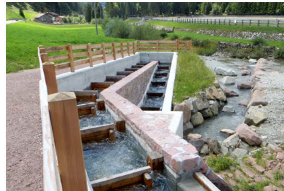
La scala pesci sul Talvera presso l'impianto idroelettrico di Sarentino.
