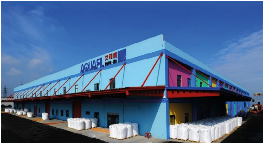
Figura 17 - Impatto visivo dello stabilimento cinese di JIAXING
