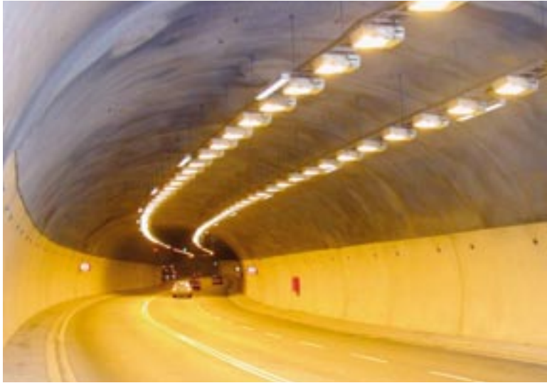
Fig. 6: L'applicazione di pannelli in cemento bianco riduce l'esigenza di illuminazione in gallerie sotterranee.
