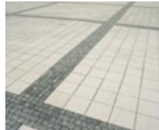
Pavimentazione in piastrelle, cemento bianco
