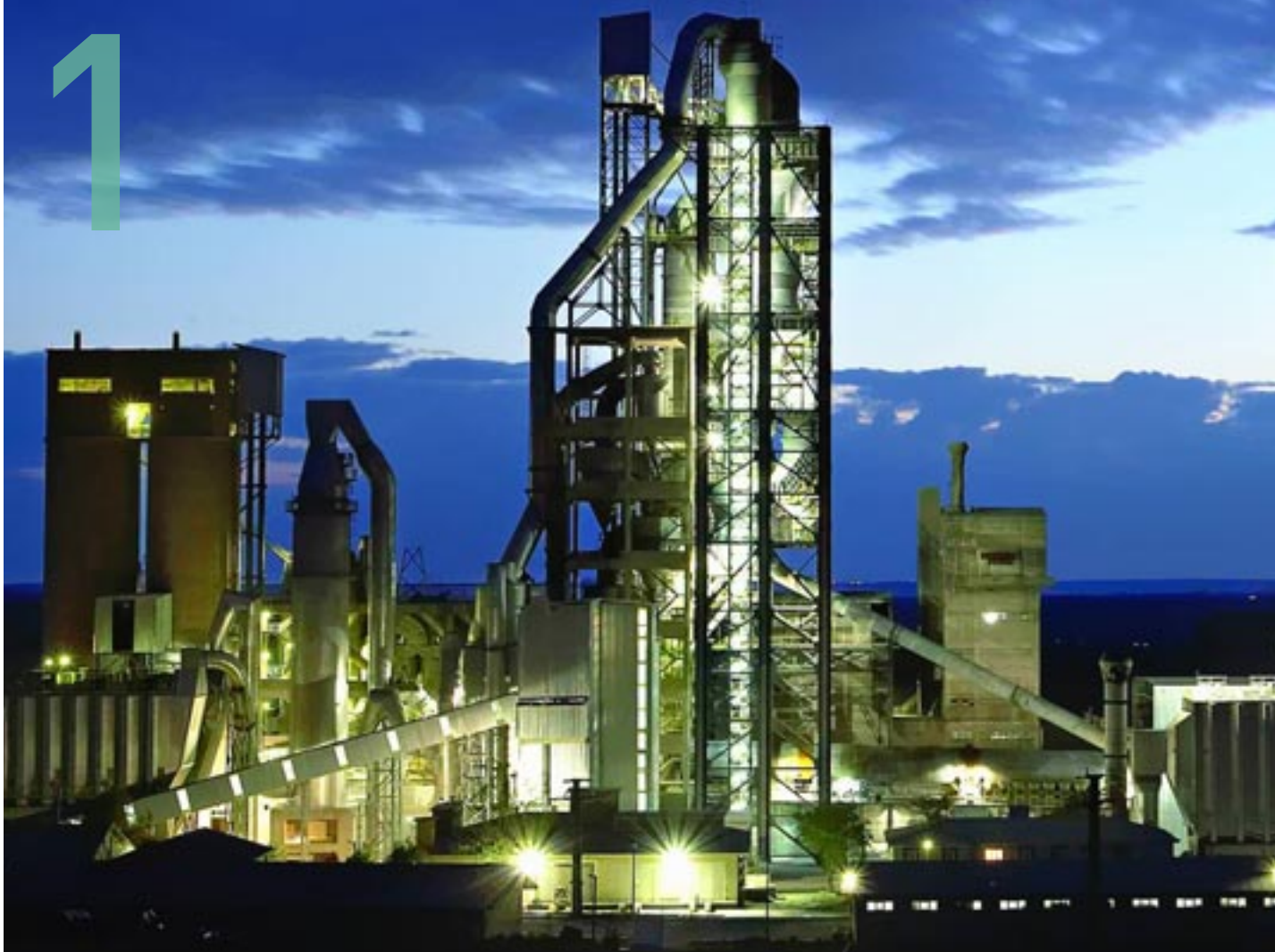
Impianto di cemento ad Edirne, Turchia
