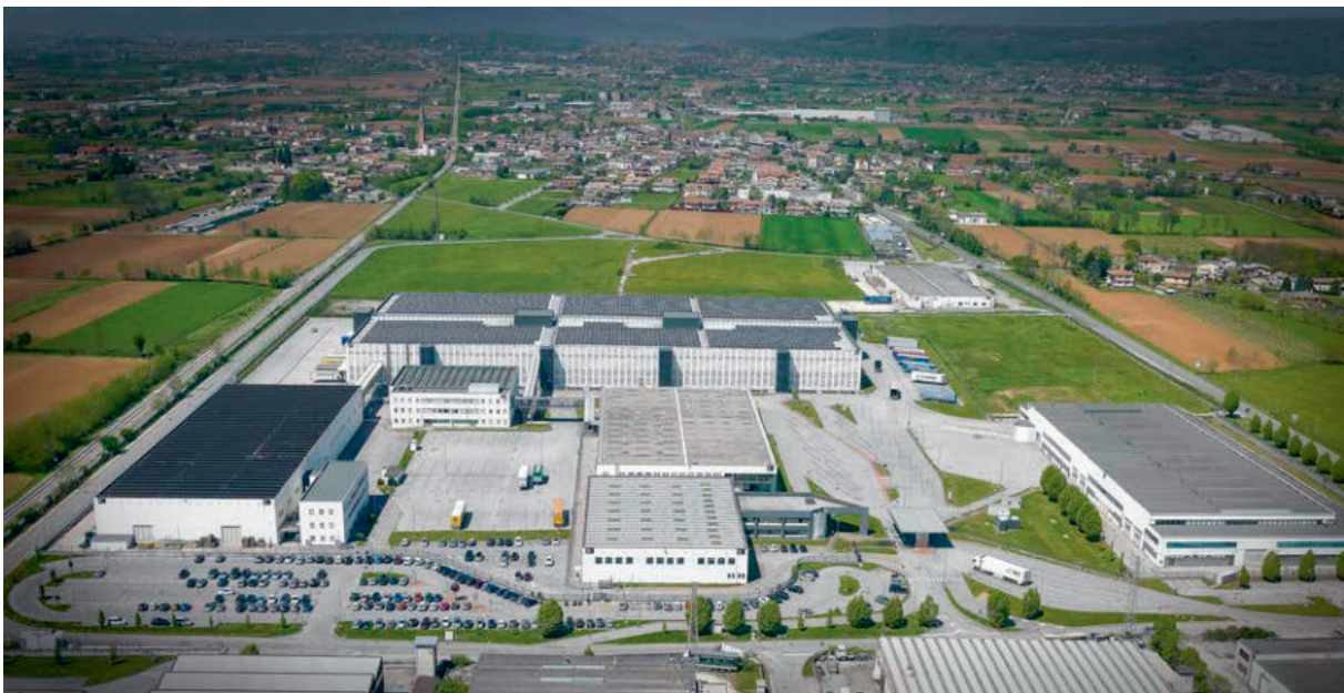
Logistics Centre - Signoressa di Trevignano
