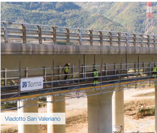
Posa dei cavi all'interno di un viadotto
