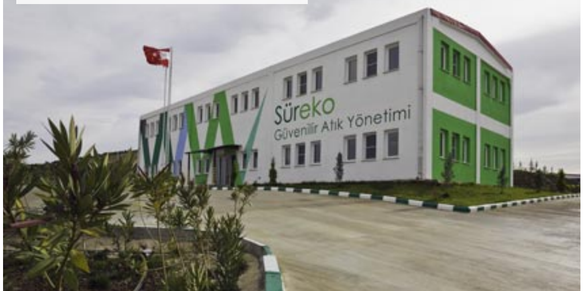
Impianto per il trattamento dei rifiuti a Kula, Turchia
