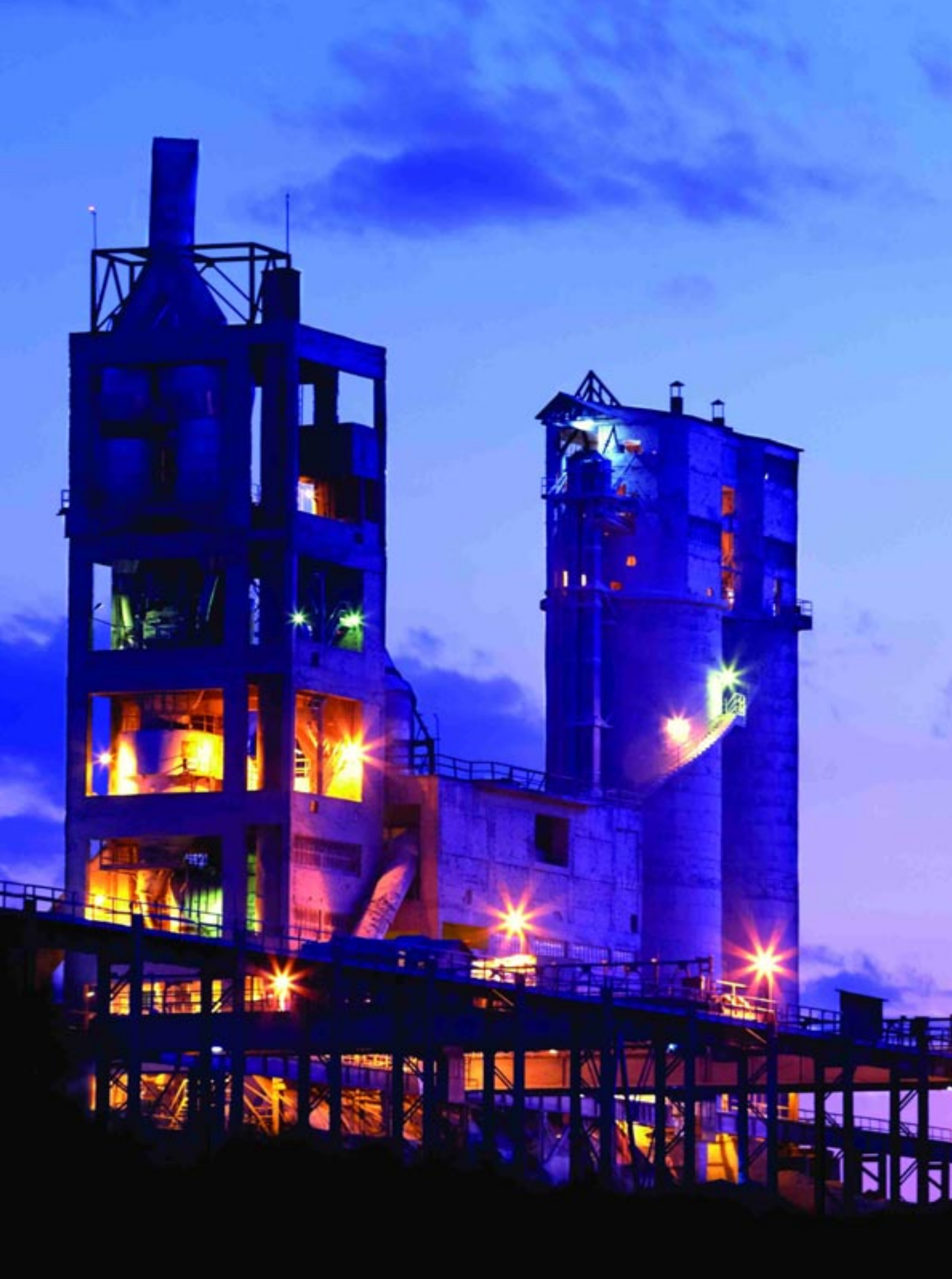
Impianto di cemento a Kars, Turchia
