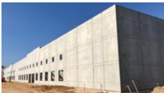
(c): Elementi prefabbricati in calcestruzzo per un'abitazione a più piani
