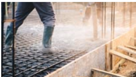
(b): Calcestruzzo gettato in opera per un ponte stradale
